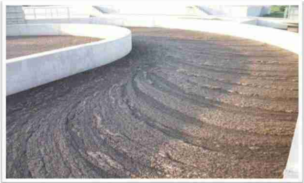
Resim 22: Tesisteki Havuzların Köpük ile Kaplanması
