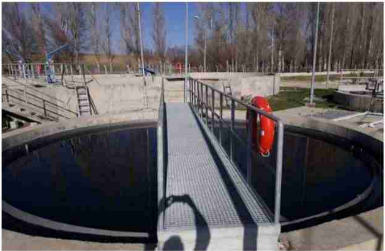
Resim 28: Düzağaç Atıksu Arıtma Tesisi Son Çöktürme Havuzları
