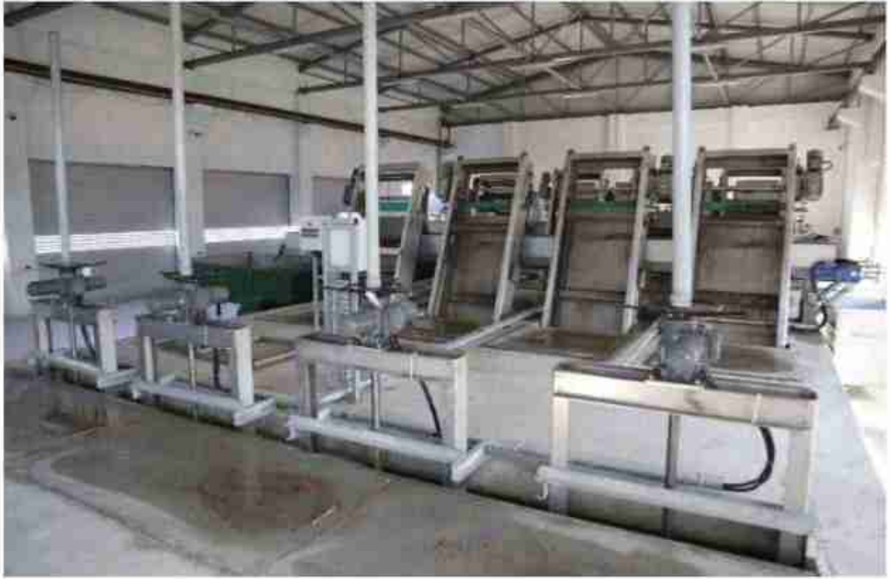
Resim 4: Yeni İzgara Yapısı
