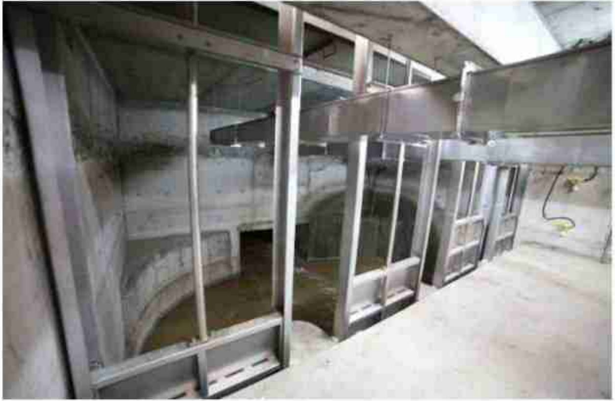
Resim 6: Yeni İzgara Yapısı
