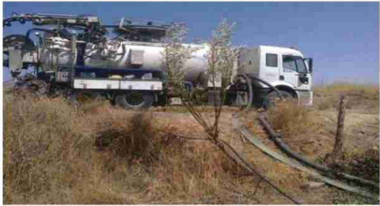
Resim 33: Kırık Köyü Foseptik Temizleme Çalışması
