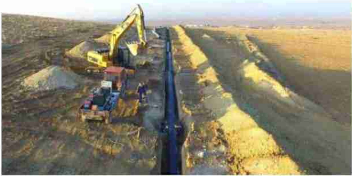
Resim 37: Sulama Sistemi İnşaatı
