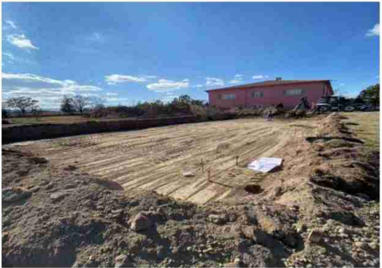
Resim 42: Mikrobiyoloji Laboratuvarı İnşaatı
