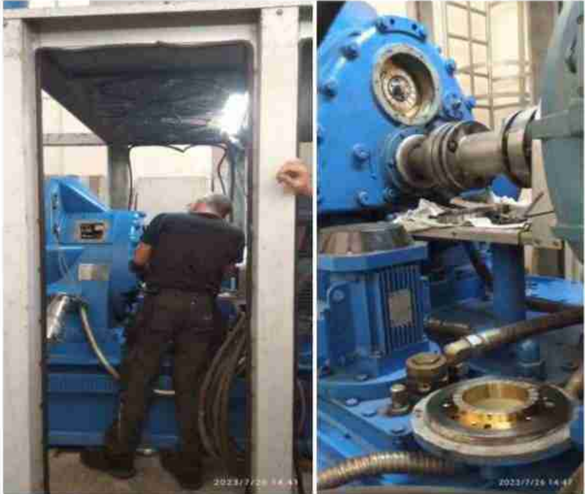
Resim 76: Turbo Blower Türbin Bakımları
