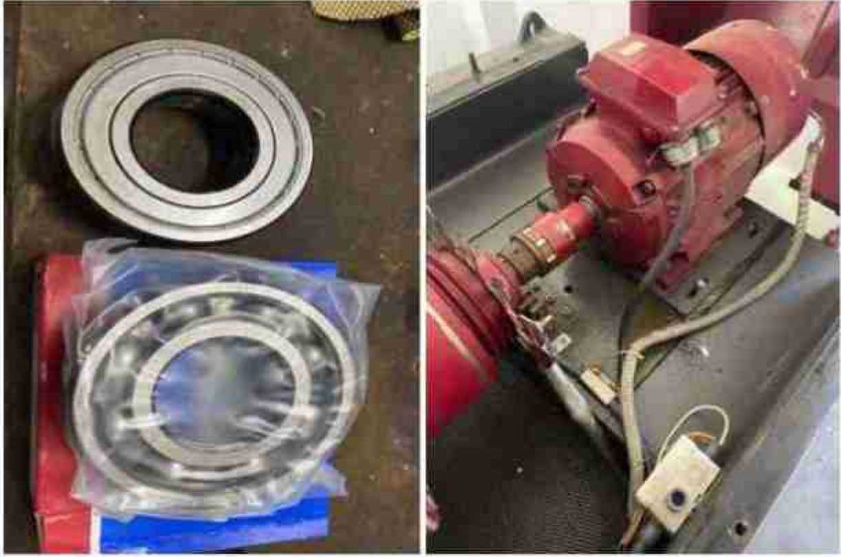
Resim 79: Dekantör Elektrik Motorları Rulman Değişimi
