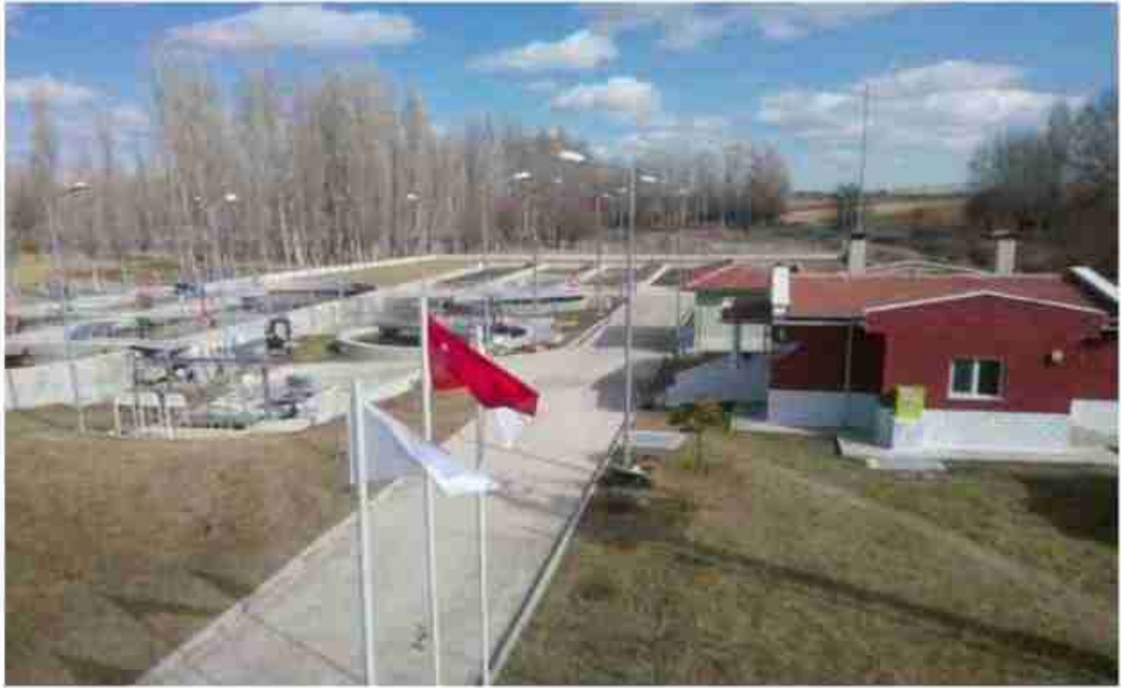
Resim 25: Düzağaç Atıksu Arıtma Tesisi Genel Görünüm
