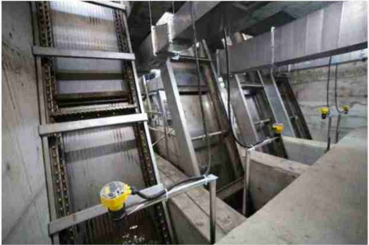
Resim 5: Yeni İzgara Yapısı
