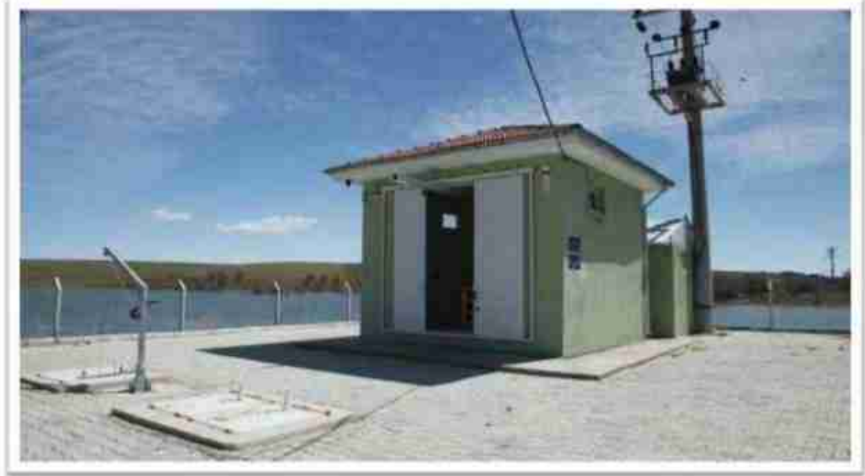
Resim 30: Düzagaç Terfi İstasyonu
