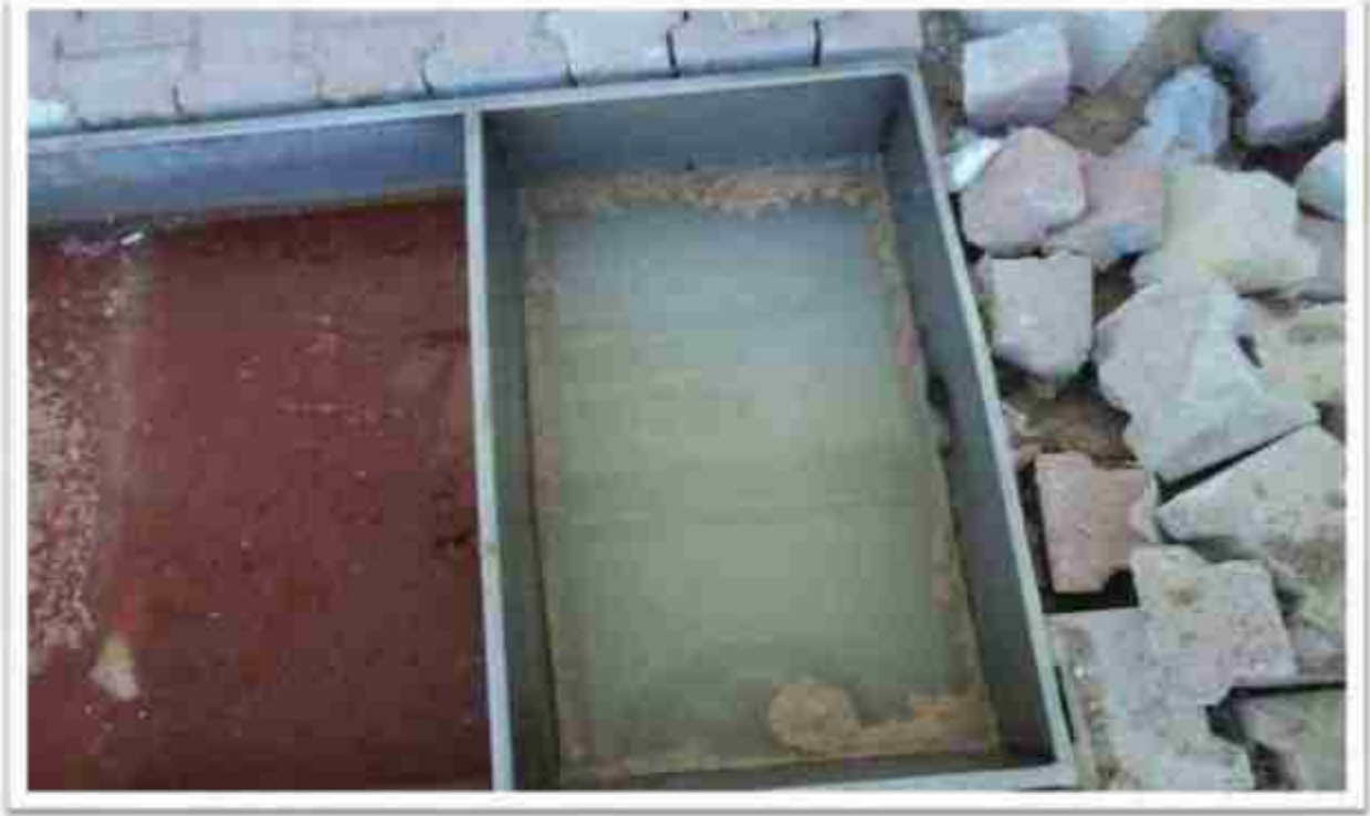
Resim 24: Yağ tutucu çıkış kısmı
