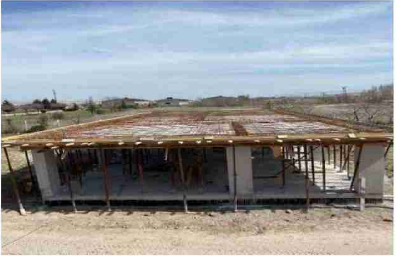
Resim 43: Mikrobiyoloji Laboratuvarı İnşaatı
