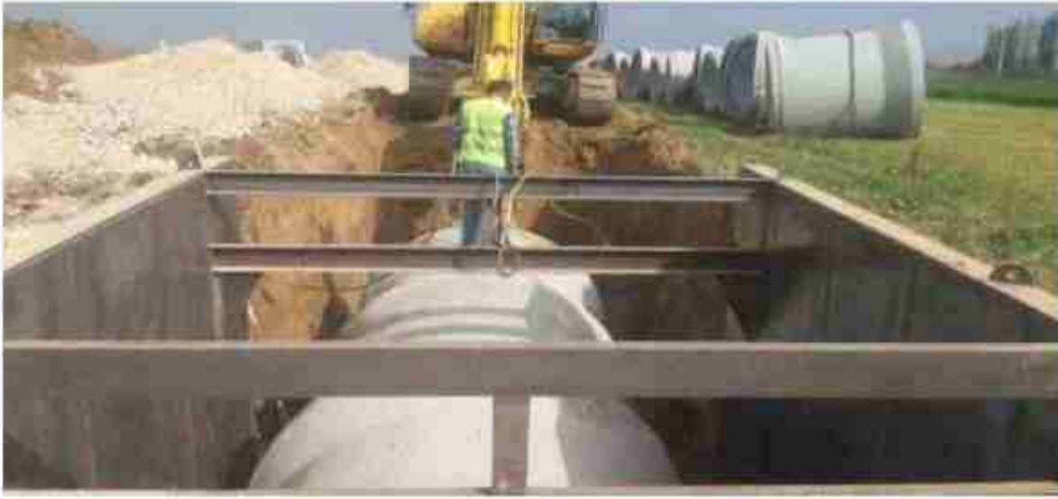
Resim 2: Kuzey yakası kolektör hattı inşaatı
